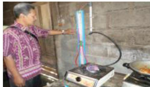
Gambar 7. Digester biogas dengan memanfaatkan kotoran ternak sapi di Desa Umbulharjo, Cangkringan, Sleman, Provinsi DI Yogyakarta
