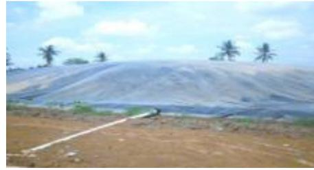
Gambar 16. Pengembangan biogas dengan tipe digester sederhana di Desa Sri Rejeki, Kecamatan Negeri Katon, Lampung Selatan.
